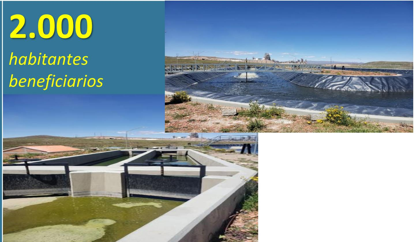
**Objetivo:** Ejecución red de alcantarillado sanitario en 4 distritos del municipio de Viacha, el agua colectada posteriormente será tratada en la PTAR, que es la primera Planta de Tratamiento con tecnología apropiada que permitirá lograr un efluente con condiciones adecuadas para su posterior vertido al río Pallina.
