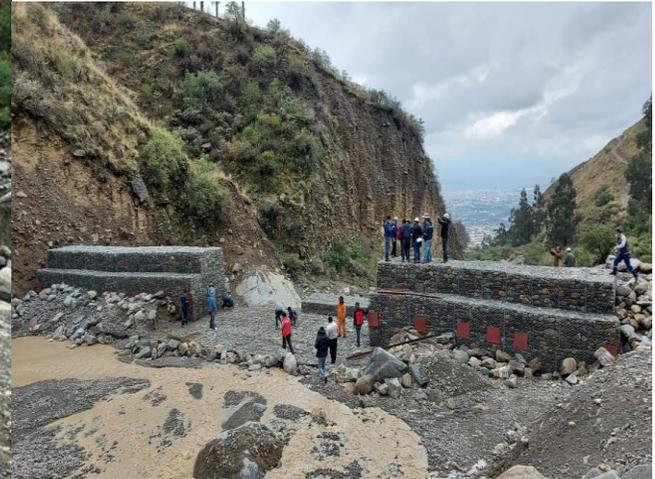
**Objetivo:** Reducir y controlar el arrastre de sedimentos sobre el río Taquiña. Controlar y amortiguar los caudales de crecida sobre el río Taquiña. Contribuir al manejo integral de cuenca sobre el río Taquiña. Mitigar los desastres naturales causados por el arrastre de sedimentos y crecidas del río Taquiña.
